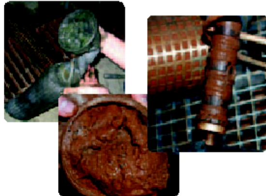
(Рис. 4) Шлам в теплообменнике.
